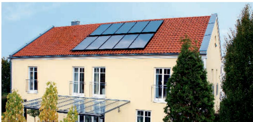
Vitosol 200-F SV2E esempio di installazione per integrazione a tetto
